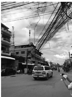
オールドマーケット周辺道路
