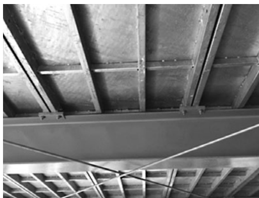
鉄板裏面(天井) ドブ漬け
