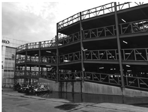
道路側からのアングル
