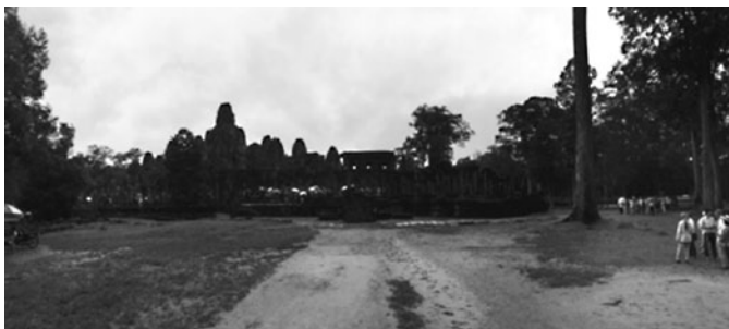
寺院を取り囲む外壁
