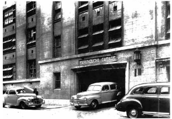
丸ノ内ガラーヂビル
