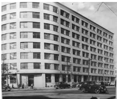
(第一次工事竣工直後の東京ビル)
