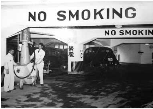
(東京ビル地下G・簡易給油所・禁煙厳守)
